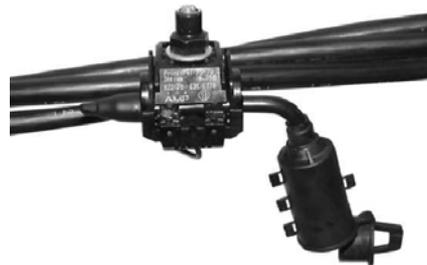
Адаптер устанавливается со стороны ответвления в зажимах с прокалыванием изоляции (типа HEL или KZ2, см. стр. 4,5) обычно в месте окончания или пересечения линии. Для доступа к бронзовому втычному контакту с фиксатором удаляется изолирующая заглушка. Втычной контакт имеет отверстие для проверки отсутствия напряжения. Присоединение к системе заземления выполняется с помощью специального набора.
