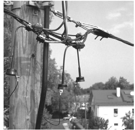
Низковольтные ОПН монтируются в местах соединения СИП до 1кВ с подземными или абонентскими кабелями и на подстанциях. Metalloxидные варисторы, встроенные в ОПН, надежно защищают сеть и подключенное оборудование от всех видов перенапряжения. Набор крепежной арматуры, например, изолированный проводник и монтажные кронштейны, отвечает индивидуальным требованиям заказчиков.
